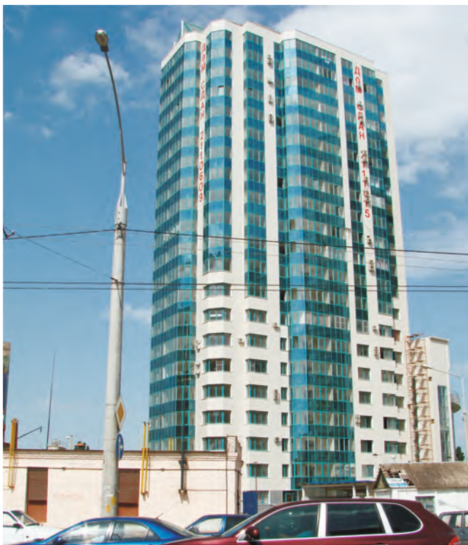
Жилой комплекс «Адмирал» (г. Краснодар, Кубанская набережная), 2010 г.
